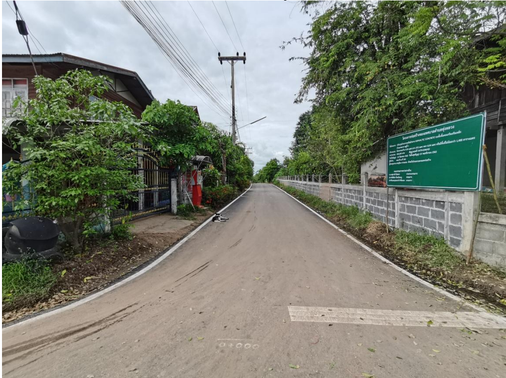
ปรับปรุงผิวจราจรเสริมผิวทาง Asphaltic Concrete บนชั้นพื้นคอนกรีตเสริมเหล็ก บ้านตาหยวก หมู่ที่ ๑
