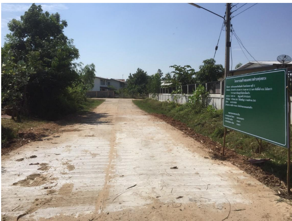
ก่อสร้างถนนคอนกรีตเสริมเหล็ก บ้านสระโพนทอง หมู่ที่ ๑๒
