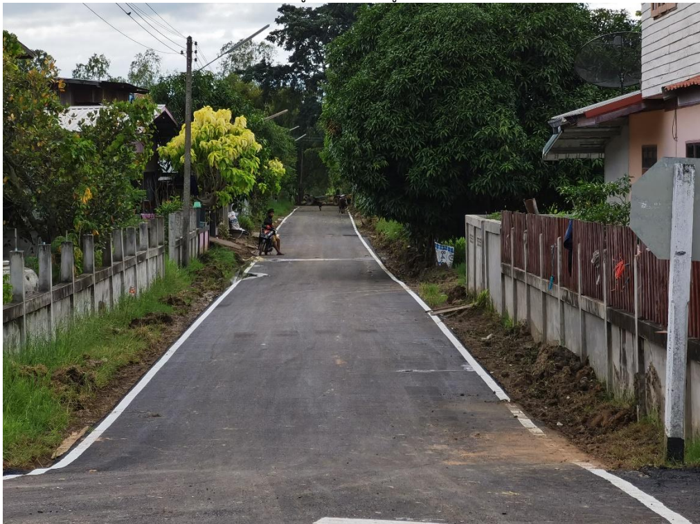
ปรับปรุงผิวจราจรเสริมผิวทาง Asphaltic Concrete บนชั้นพื้นคอนกรีตเสริมเหล็ก บ้านคูดินทราย หมู่ที่ ๑๑
