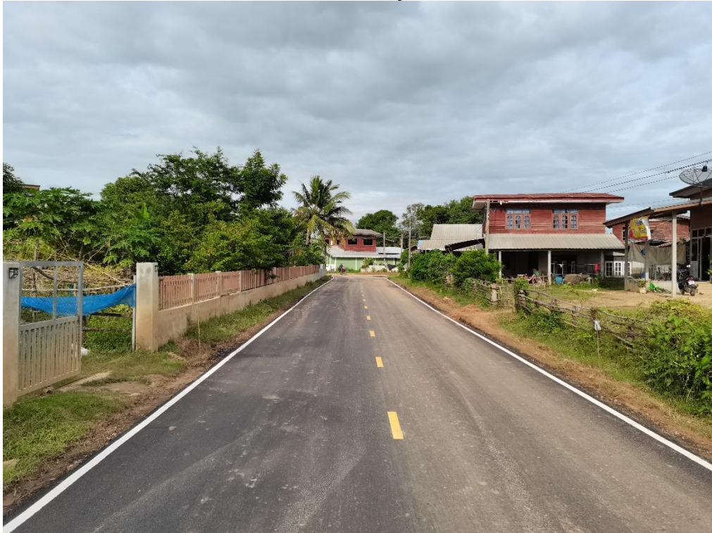
ปรับปรุงผิวจราจรเสริมผิวทาง Asphaltic Concrete บนชั้นพื้นคอนกรีตเสริมเหล็ก บ้านโพนเตื่อ หมู่ที่ ๔
