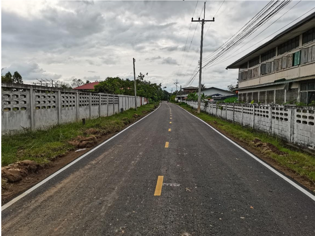
ปรับปรุงผิวจราจรเสริมผิวทาง Asphaltic Concrete บนชั้นพื้นคอนกรีตเสริมเหล็ก บ้านสระโพนทอง หมู่ที่ ๘
