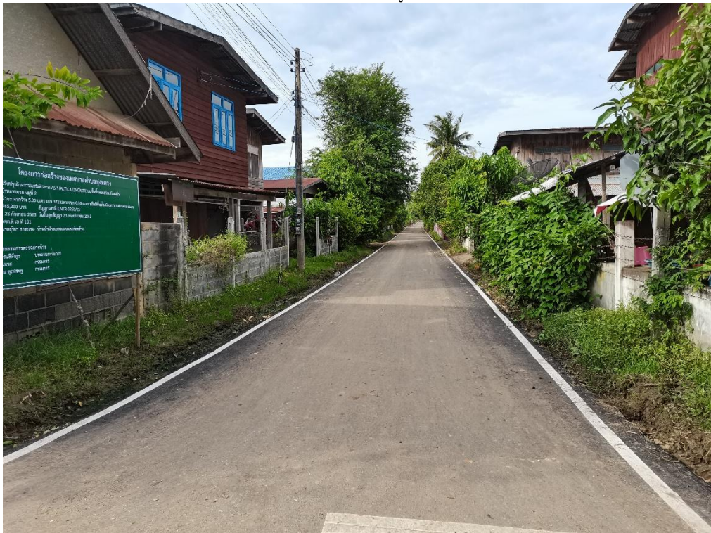
ปรับปรุงผิวจราจรเสริมผิวทาง Asphaltic Concrete บนชั้นพื้นคอนกรีตเสริมเหล็ก บ้านตาหยวก หมู่ที่ ๒
