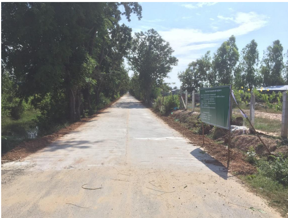
ก่อสร้างถนนคอนกรีตเสริมเหล็ก บ้านสระโพนทอง หมู่ที่ ๘
